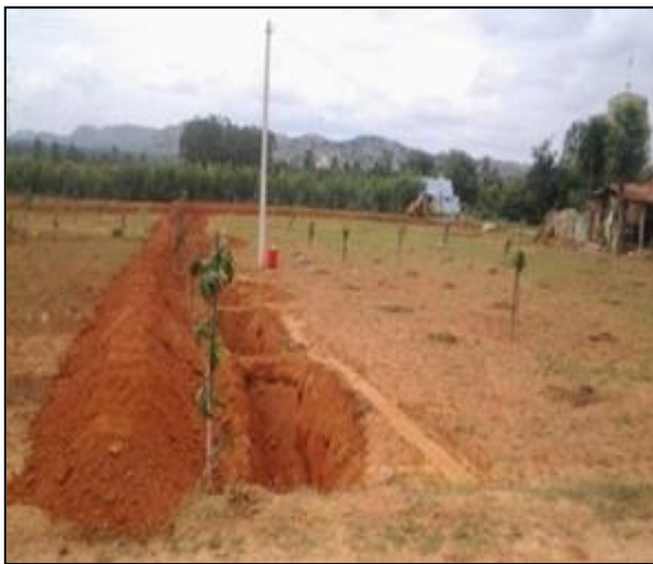
Trench cum bund, Mudavatti
